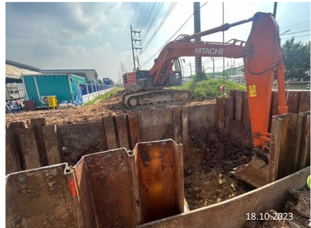
ก) งานจัดเตรียมพื้นที่ก่อนเริ่มดำเนินงาน (Site Clearing & Grading) และงานวางท่อด้วยวิธี Open Cut
