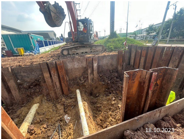
ก) งานจัดเตรียมพื้นที่ก่อนเริ่มดำเนินงาน (Site Clearing & Grading) และงานวางท่อด้วยวิธี Open Cut
